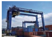
高性能无线网支撑的港口装卸远程控制系统
